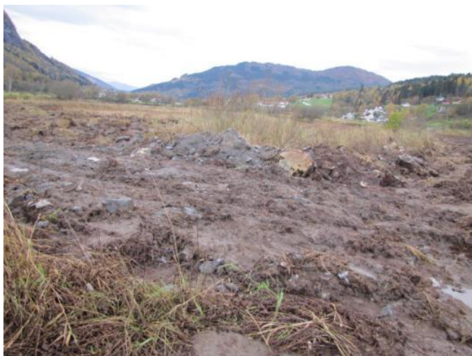
Figur 11. I kanal 1 er det dumpa massar. Desse bør fjernast, og det bør leggjast ned ein kulvert i staden for.
