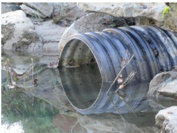
Figur 37. Ny kulvert i utløpet av Nybøløken. Denne ser ut til å ha tilstrekkelig kapasitet til å gi god kontakt mot Stryneelva.
