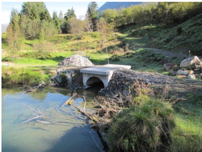
Figur 14. Kulverten i uløpet av den attgrodde kroksjøen i september 2014. Sjølv ved nokså låg vassføring i Stryneelva står det vatn høgt nok til at fisk kan vandre forbi kulverten.
