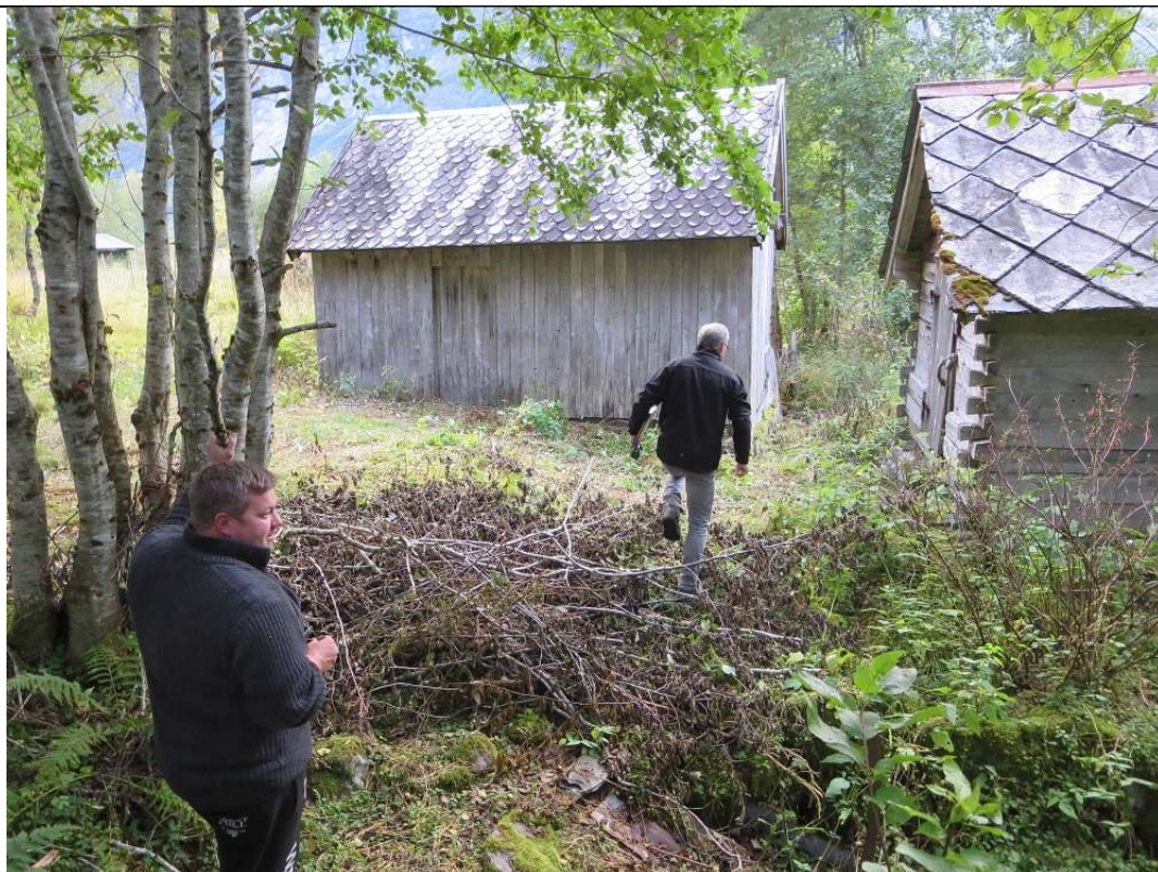
Tom Erik står i vassveita som rann rett fram på vasshjulet på kanten framfor han. Vasshjulet dreiv kavlane på veggen av ysteriet rett framfor Jan Endre, og på den same måten på kvernhuset til høgre. På bildet kan ein sjå at skifertaka på både dei to husa er godt ivaretekne.
