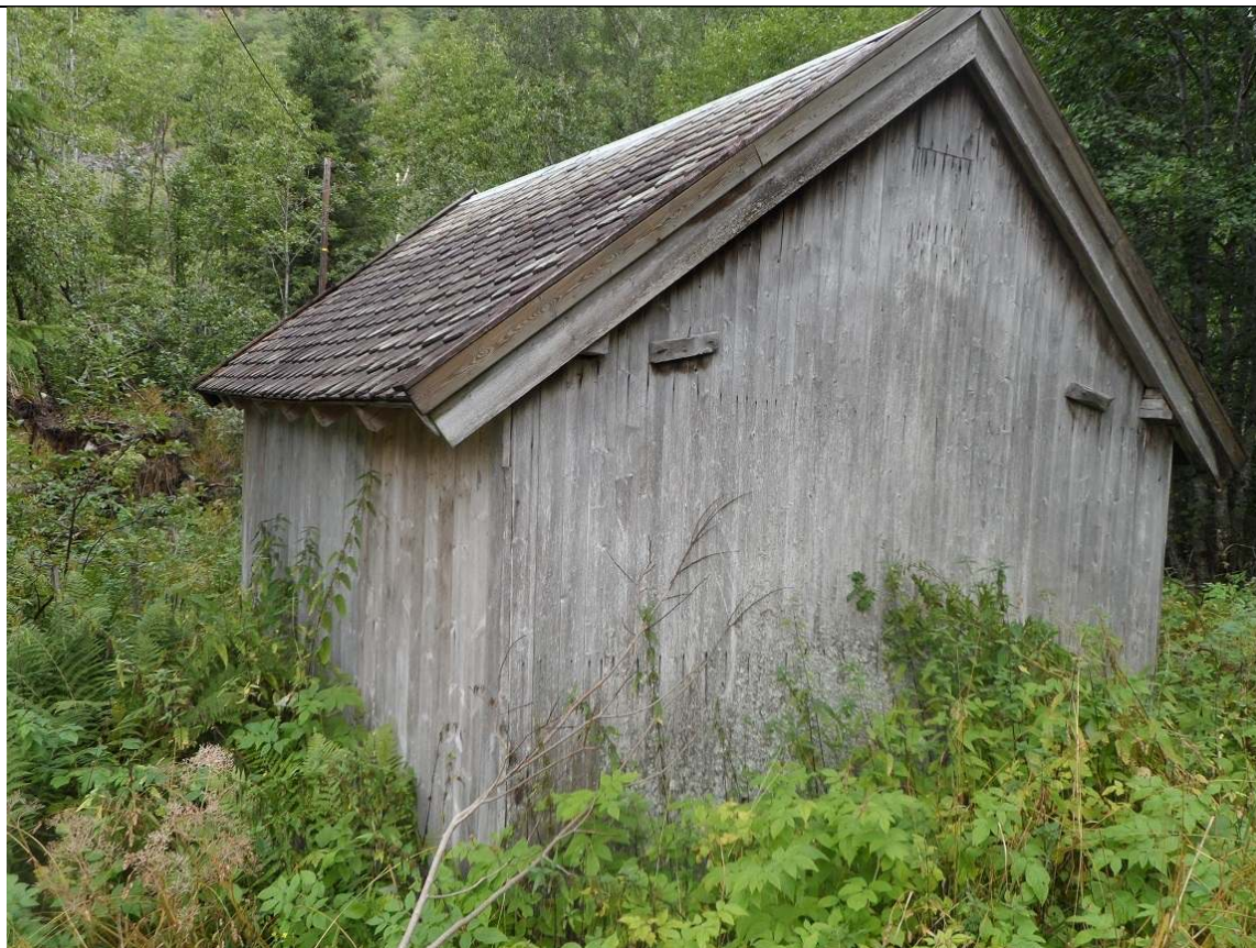
Ysteriet i Bødal og eit mindre kvernhus i bakkant, var dei to einaste bygningane som vart ståande igjen etter rasulukka i Nesdal og Bødal i 1936. Bygningen vart nytta til «sjukestove» under opprydningsarbeidet, og mange dramatiske historier knyter seg til bygget. Lodalsulukkene er dei to største rasulukkene i landet målt i antal døde.
