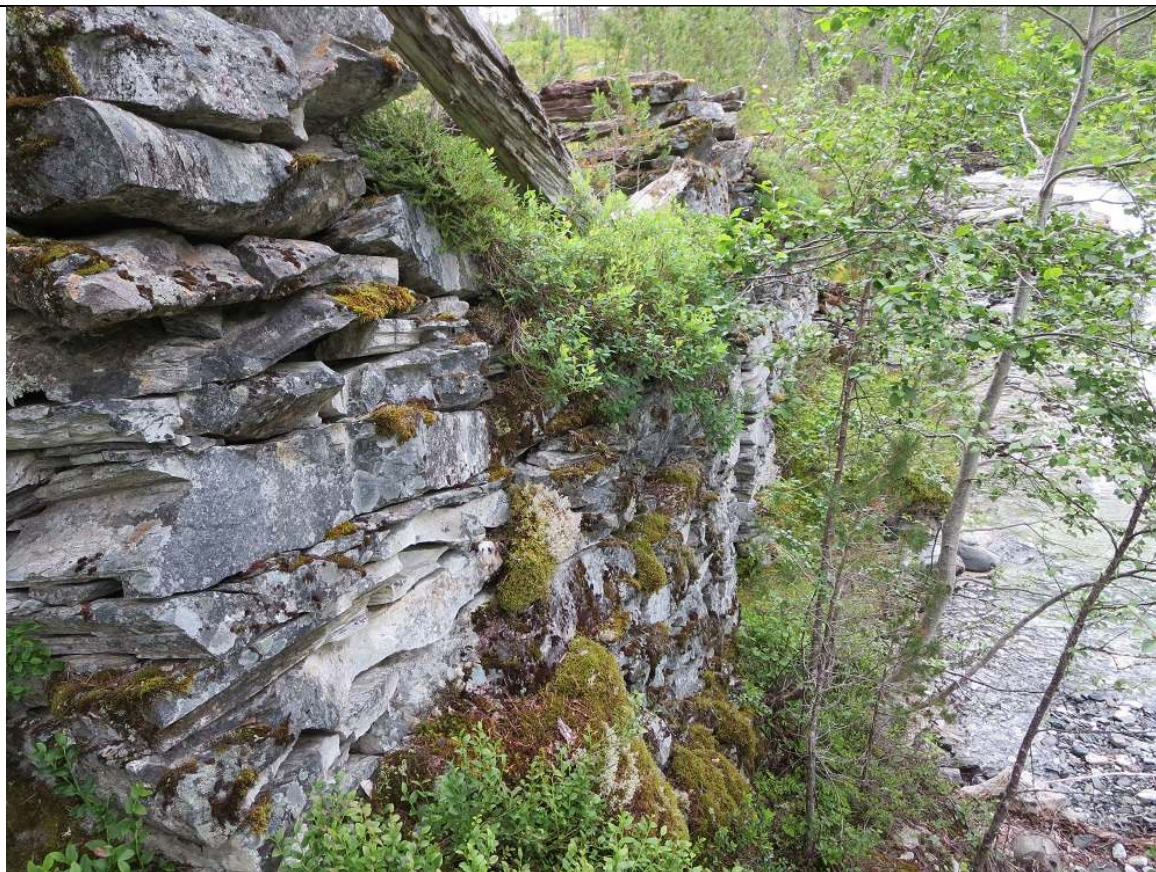
Randasaga sett frå elvesida. Saga var ei såkalla oppgangssag, med relativt liten storleik, men ein kunne saga ganske store lengder på ho.
