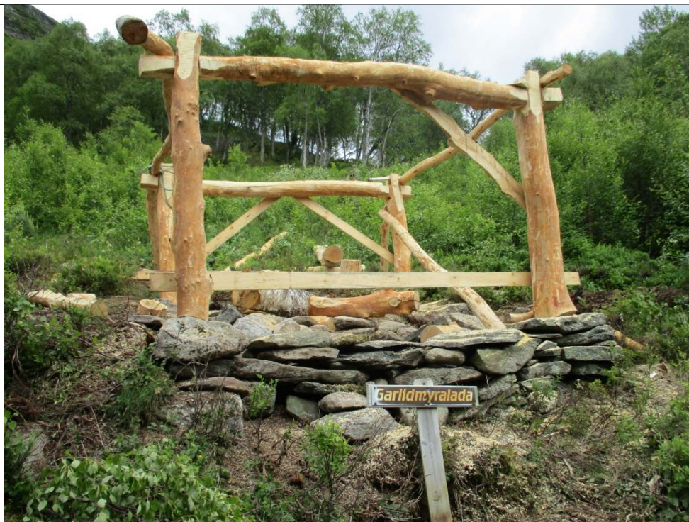
Arbeidet med å rekonstruere Garlidmyralada er i gong sommaren 2015. På bildet ser vi at grindeverket av ei ny lade er i ferd med å reise seg på dei gamle murane.
