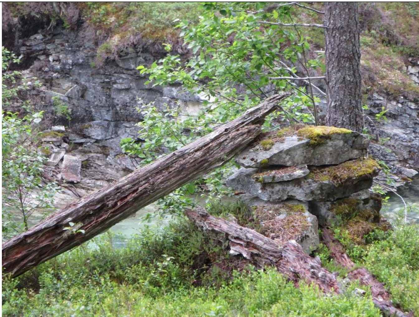
Den eine foten av fundamentet for sagbygget. Snart er det siste treverket vekke.
