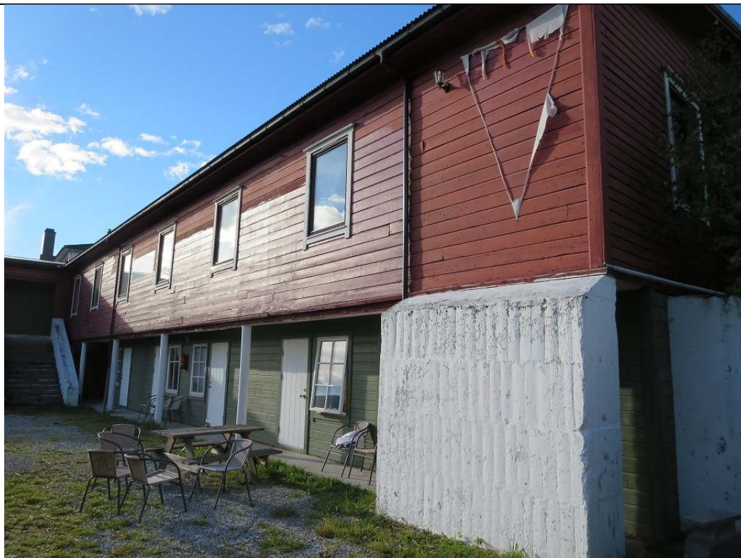
Vandrarheimen sett frå søraust. Langfløya på bygget er den intakte tyskerbrakkka. Under byggingen er det satt inn 6 rom med dusj og toalett. I vestenden kan ein sjå den påbygde delen som vart nytta som matsal.
