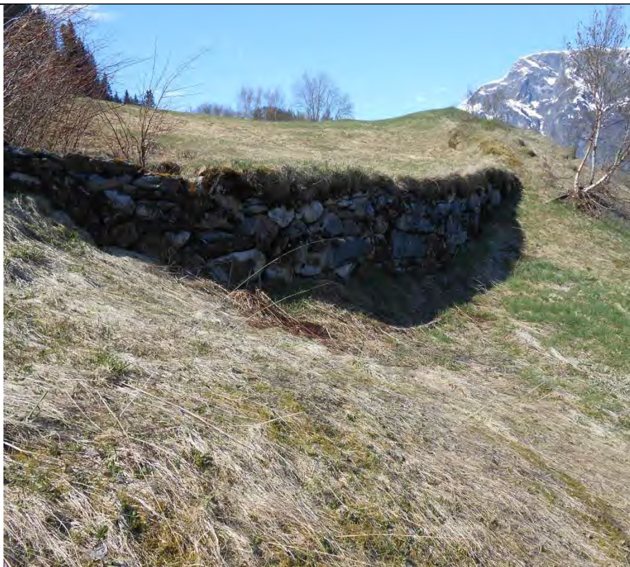
Mur for å få det flatare.
