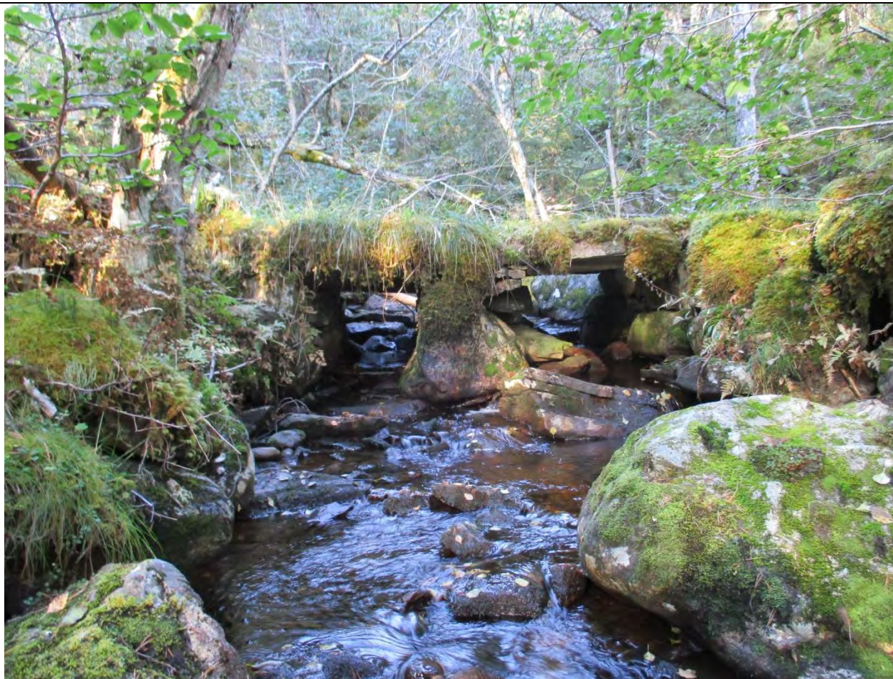
Vilkjekloppa er murt opp av solide gråsteinsheller.
