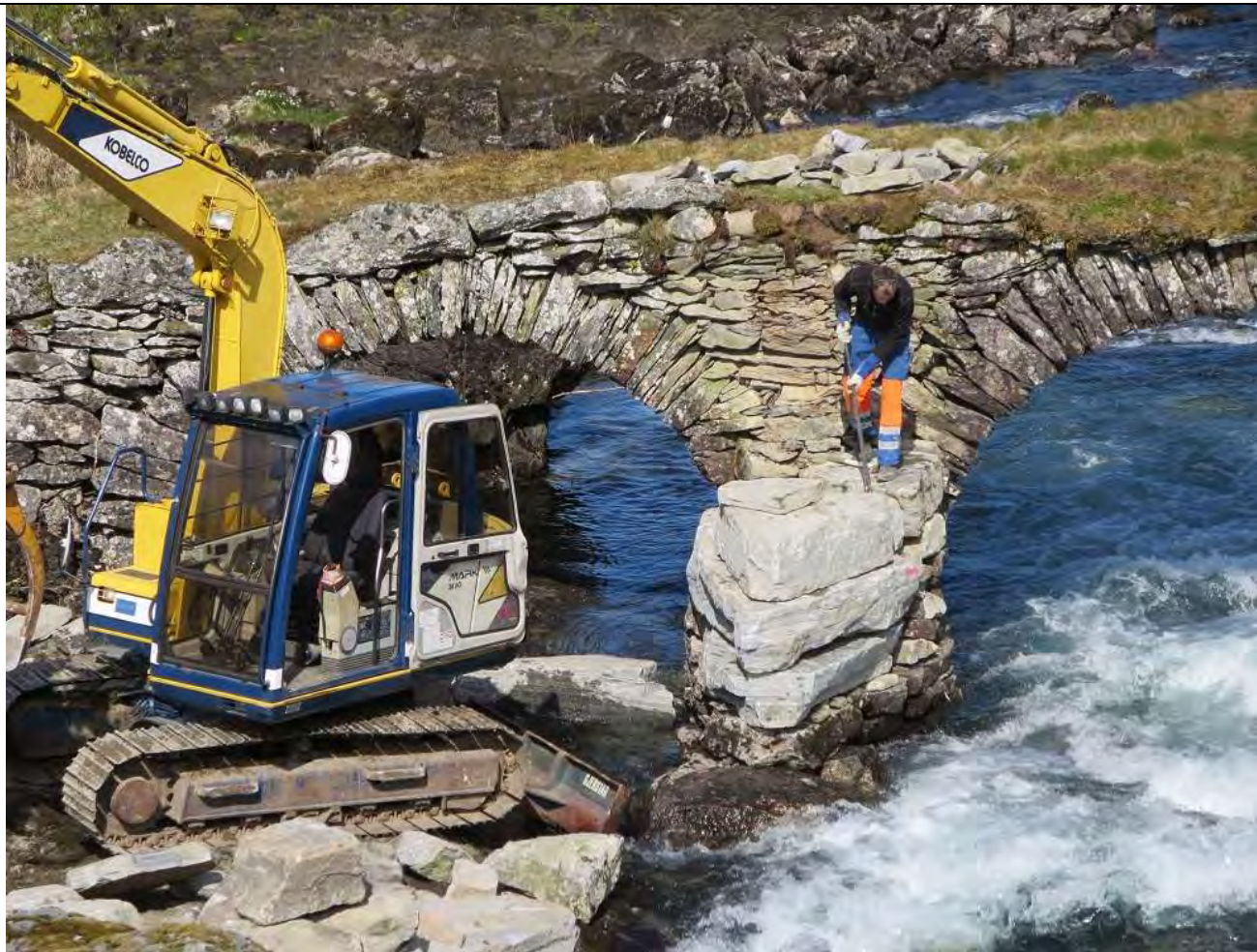
Reparasjonsarbeid på kvelvingsbrua 2015. Den vestre straumbrytaren er her plukka ned og vert (mellombels eller permanent) erstatta av mykje grøvre stein.
