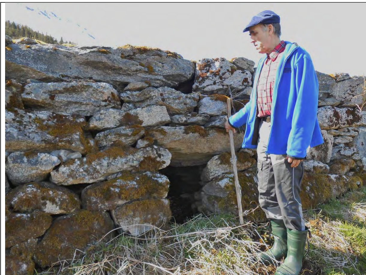
Mur med stikkrenne.
