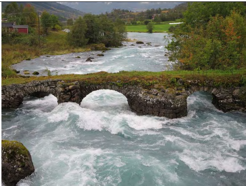
Kvelvingsbrua på Eide før restaurering av straumbrytar 2015.
